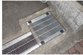
再めっきを施したグレーチング
